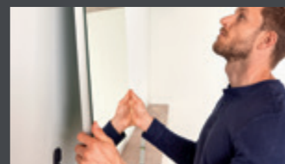
↑ Benytt deg av den ekstra klipsen for et godt feste mot vegg. Disse gir også ekstra sikring mot avkrokning
