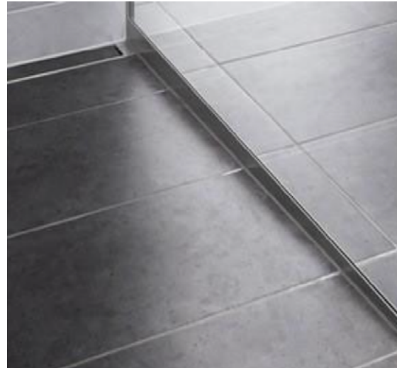
Bilde 4a og b: Bilde til venstre viser sprangkanten utformet med fugemasse. På bildet vil høyre dekkes sprangkanten med kileformet bunnprofil tilhørende glassveggen.
