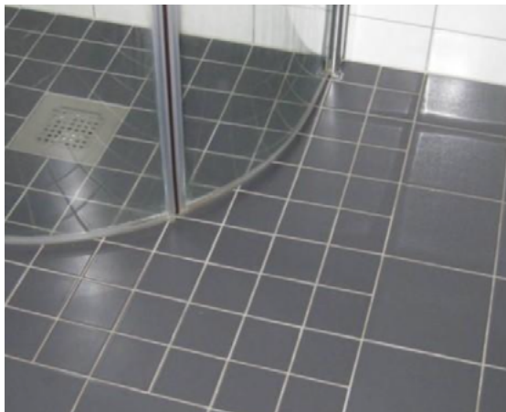
Bilde 2a og b: Rundsluk eller rennesluk? Man har full valgfrihet, men slukplassering, fallvinkel og flisformat må tilpasses hverandre.
