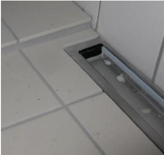
Bilde 4a og b: Bilde til venstre viser sprangkanten utformet med fugemasse. På bildet vil høyre dekkes sprangkanten med kileformet bunnprofil tilhørende glassveggen.
